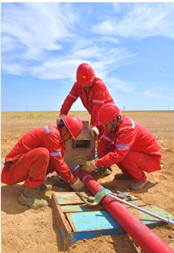
6月12日,准东钻井公司 80026 钻井队员工在钻井现场安装放喷管线点火装置。
