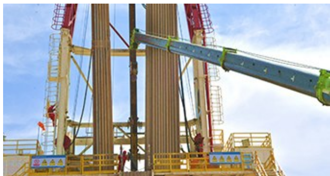
6月12日,准东钻井公司 80026 钻井队员工在烈日下开展作业。
