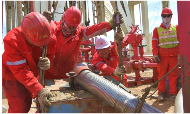
6月12日,准东钻井公司 80026 钻井队员工在钻井现场吊装设备。
