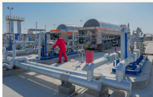
3月20日,在采油二厂八区530井区CO2混相驱先导试验站CO2卸车区,工人打开阀门,卸车罐车中的液态CO2。
