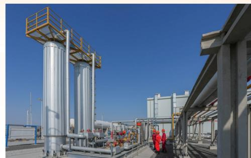
3月20日,在采油二厂八区530井区CO2混相驱先导试验站变压吸附脱碳装置区,工人正在进行设备安全检查。
