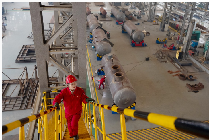
邓晓凤沿着扶梯向车间顶梁走去。
