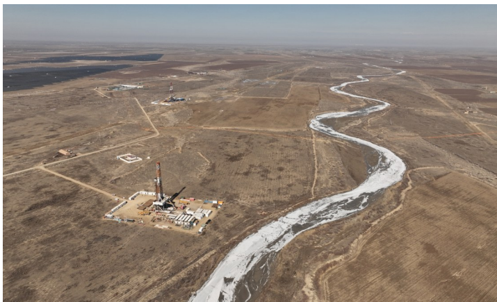
西部钻探准东钻井公司XD70506钻井队奋战在中佳区块的钻井施工现场。 周建玲 摄
