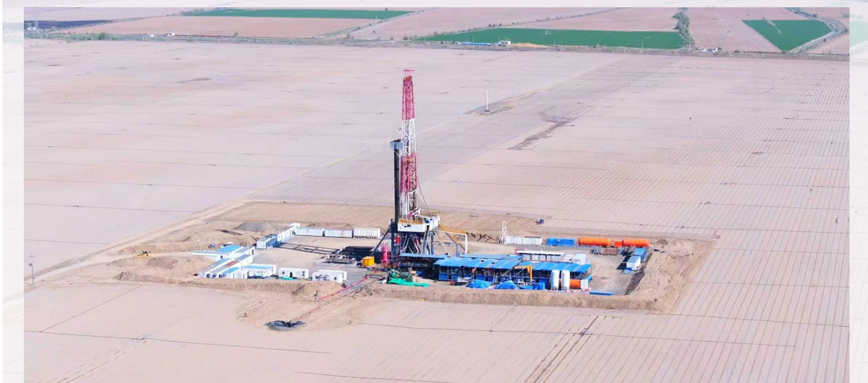
天山北麓呼图壁构造带HT1-003井钻井施工现场。
