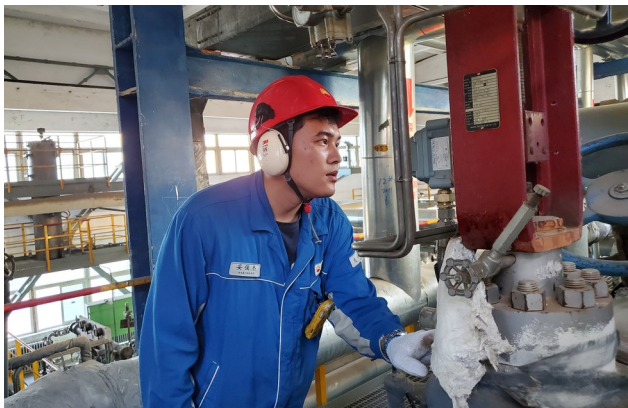
6月18日,克拉玛依石化公司一线员工在高温环境下观察设备运行情况,保障装置安全运行。 高全 摄
