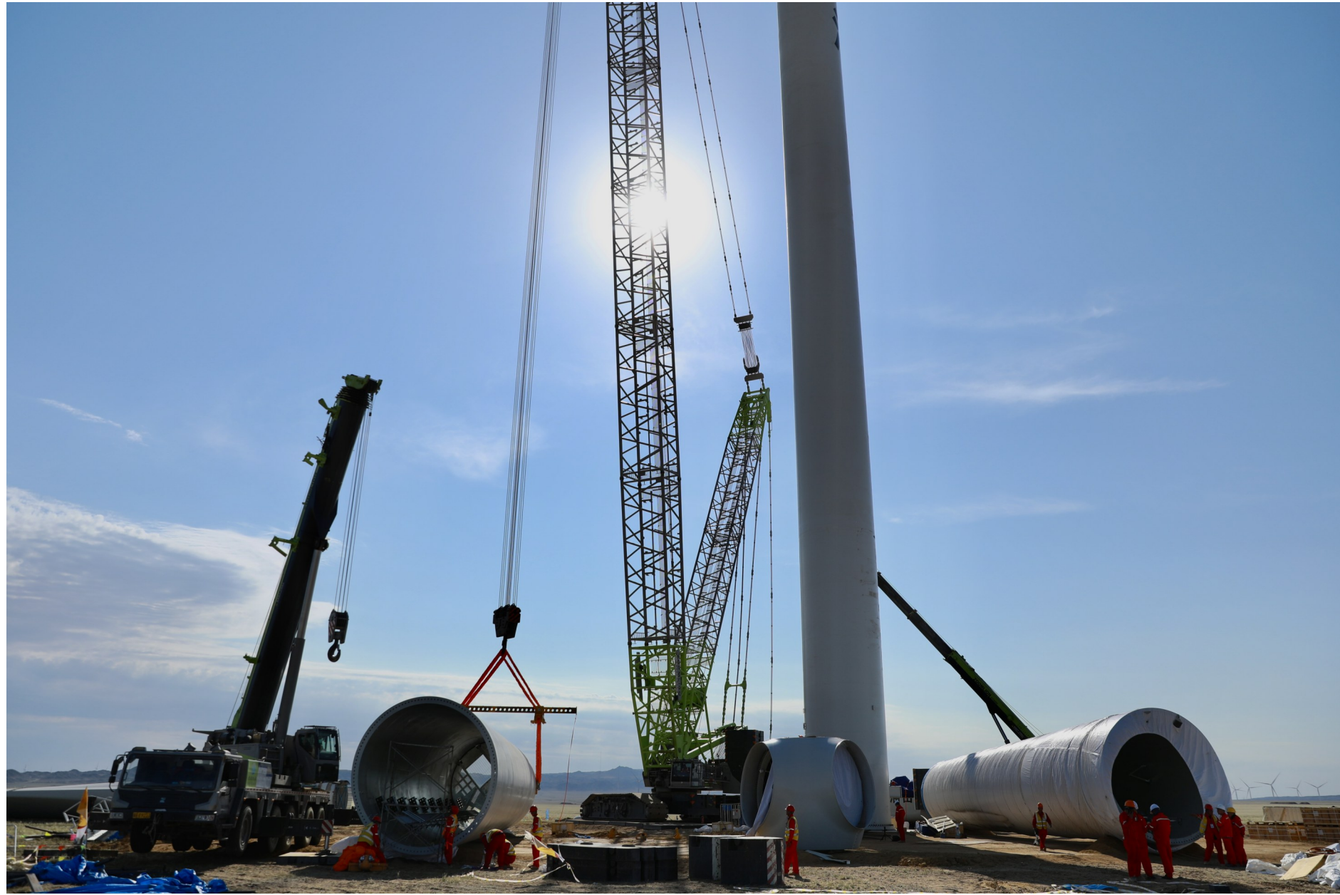
6月20日,新疆油田阿勒泰吉木乃80万千瓦风电项目现场,技术人员正在做首台风机四段塔筒吊装准备工作。 本版图片由李媛 克拉玛依融媒记者 崔文娟 摄
