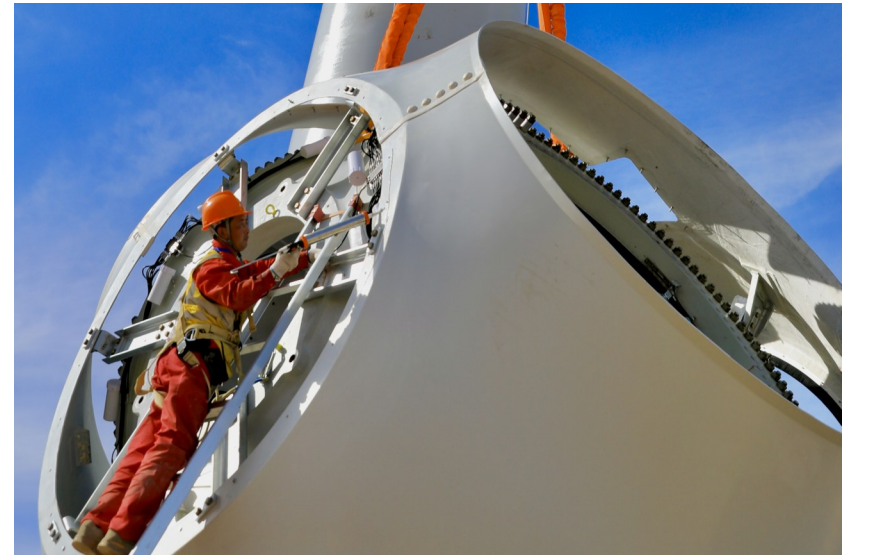
轮毂导流罩安装前,施工人员正在打密封胶。
