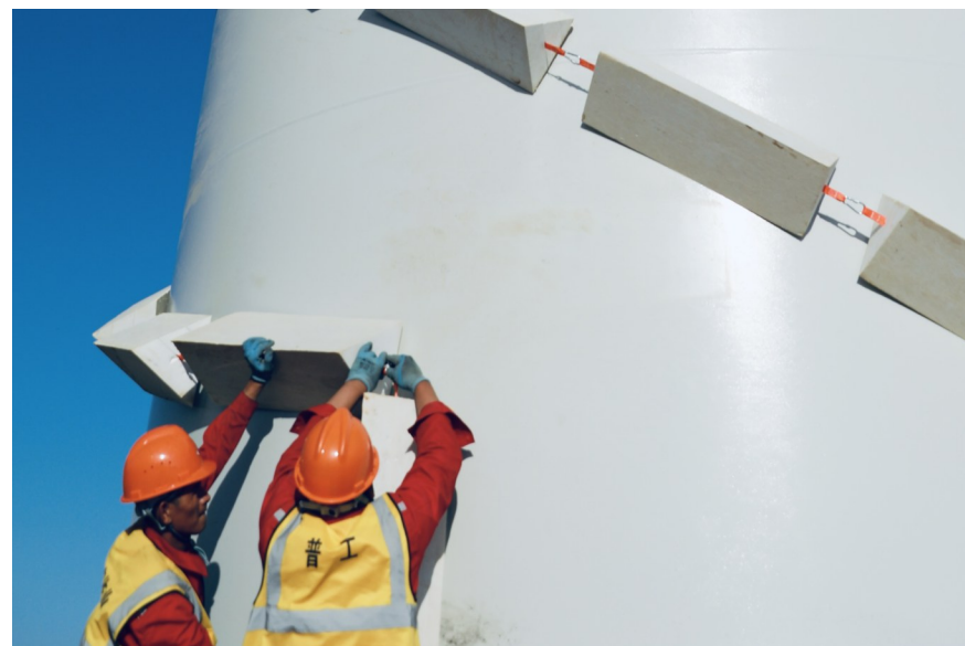
两位施工工人正在安装五段塔筒扰流条。
