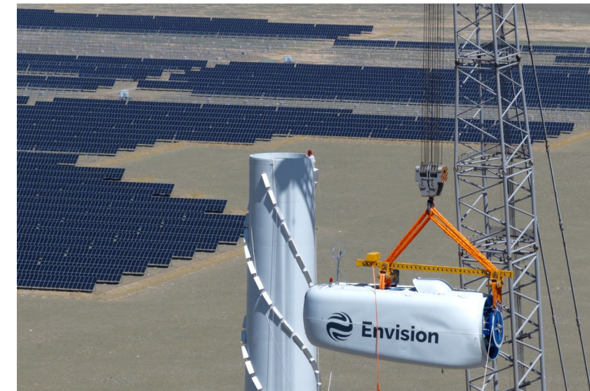
巨型吊装机正在缓缓将风机机舱送上塔顶。
