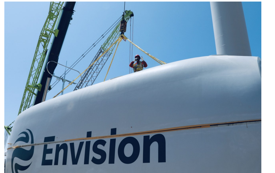
设备吊装人员正在仔细检查机舱吊装的绳索。
