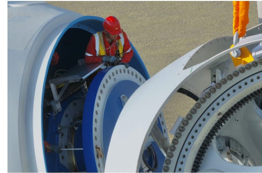
施工人员在高空中进行轮毂与机舱的对接。
