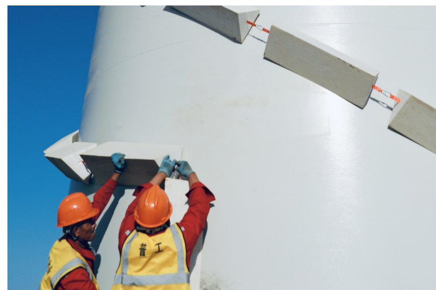
两位施工工人正在安装五段塔筒抗流条。
