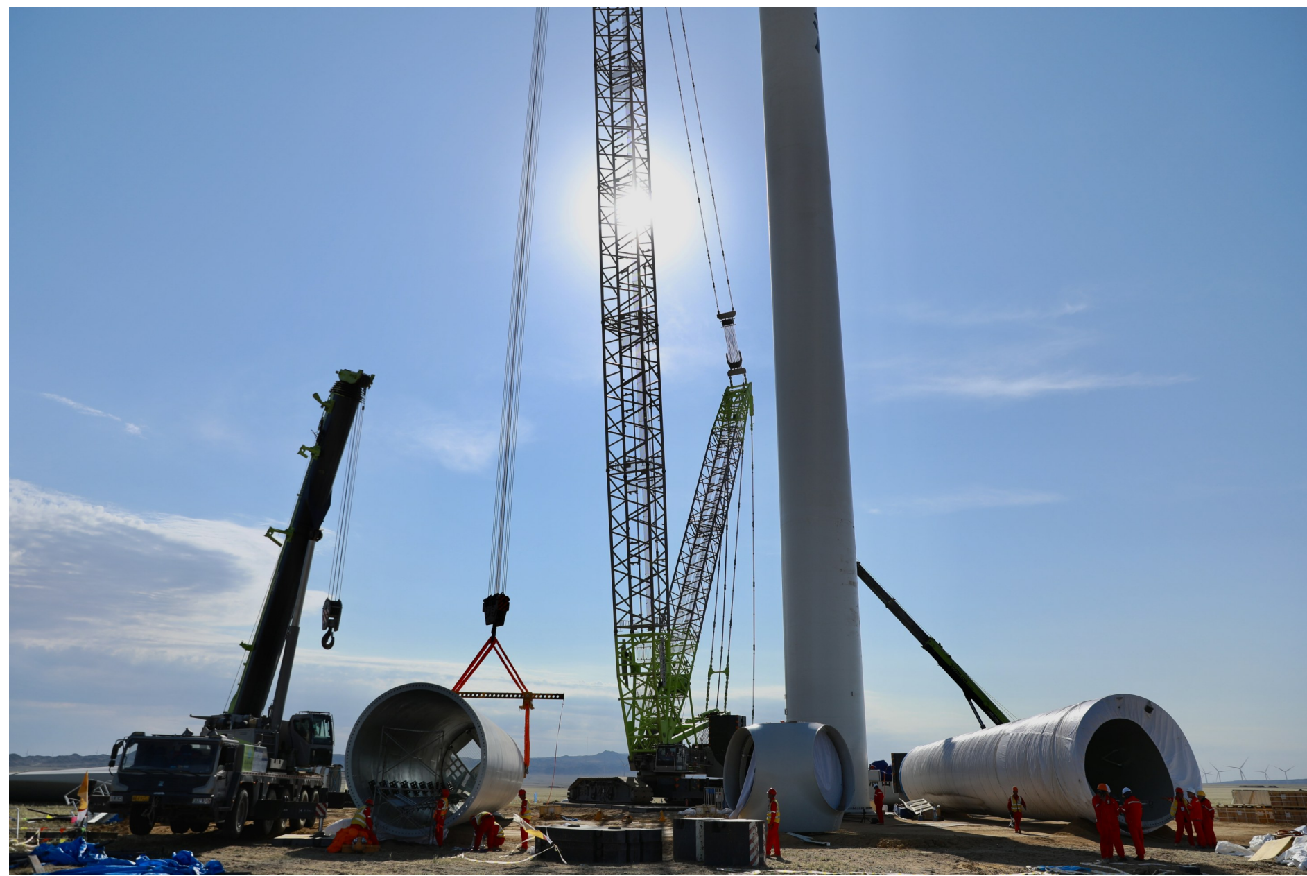
6月20日,新疆油田阿勒泰吉木乃80万千瓦风电项目现场,技术人员正在做首台风机四段塔筒吊装的准备工作。本版图片由李媛 克拉玛依融媒记者 崔文娟 摄
