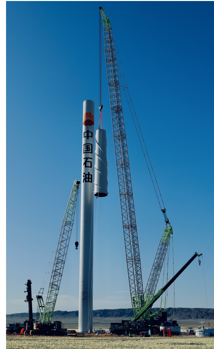
巨型吊装机正在缓缓将风机机舱送上塔顶。
