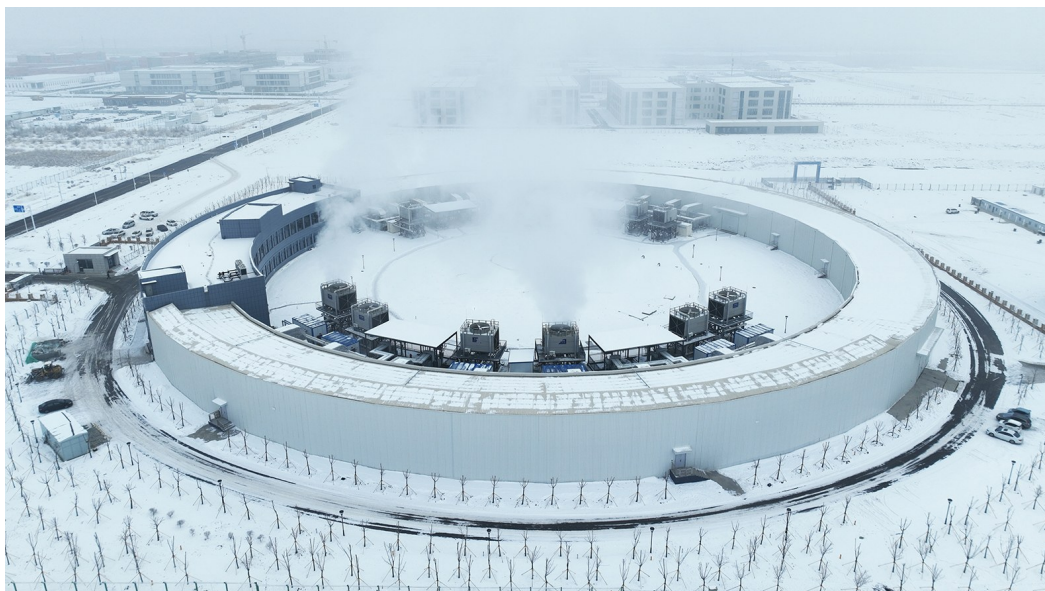
克拉玛依融媒记者 李浩然 摄(本报资料图) 2024年1月,碳和水冷数据中心开始自主绿色供暖。该中心由上海一家企业在我市注册成立。
